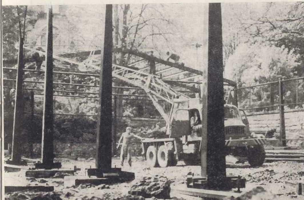
† Výstavba dílen a garáží
