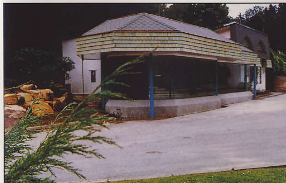
Rekonstruovaný pavilon lidoopů – vítězná stavba v soutěži „Expozice roku“.
