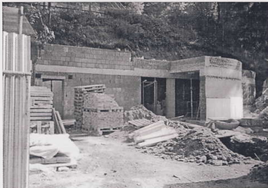
Přístavba sociálního zařízení pro návštěvníky (Annex building of the social equipment for visitors)
