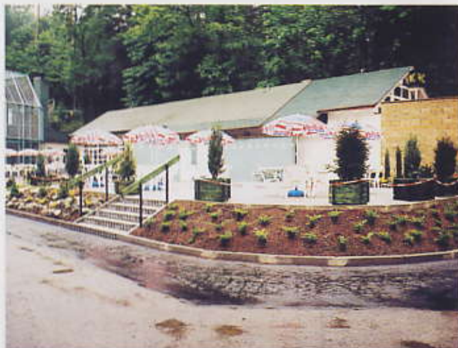
pohled na nové sociální zařízení s terasou View of the new sanitary facilities for visitors with a platform
