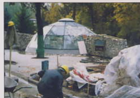
stavba zimoviště pro plameňáky - 14. 10. 2003 construction of inside enclosure for flamingoes - 14. 10. 2003
