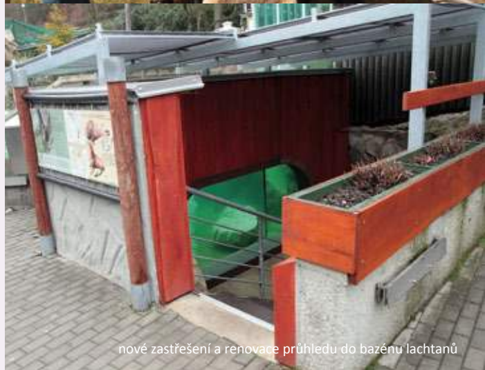
22. 8. 2013 byl položen základní kámen stavby nového vchodu
