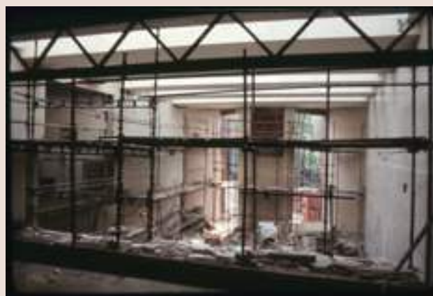
Probíhající stavba interiéru pavilonu žiraf v 80. letech
