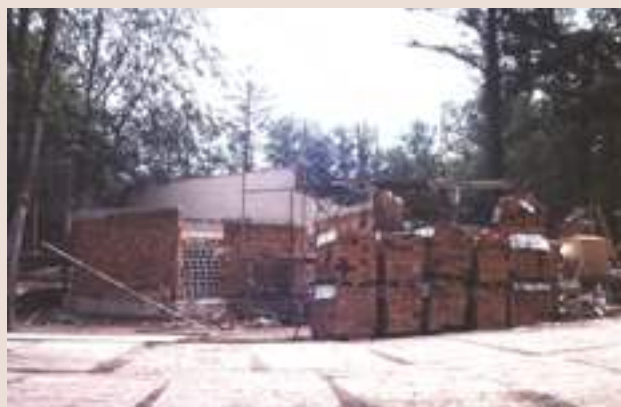
Zahájení stavby žirafince v 80. letech
